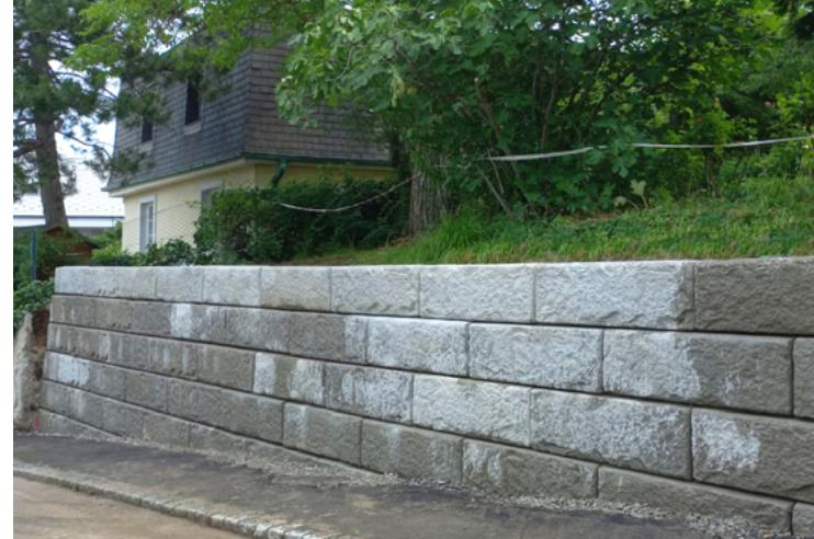
Eine bestehende Stützwand in Wien musste aus statischer Sicht abgetragen und durch eine neue Stützwand ersetzt werden. Durch die schnelle Versetzeleistung kam das SW-Stützwandsystem zur Ausführung.
